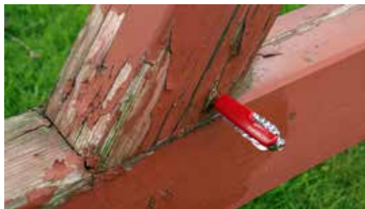
Fra provstesyn: Kniv dybt i rådden egeplanke.
