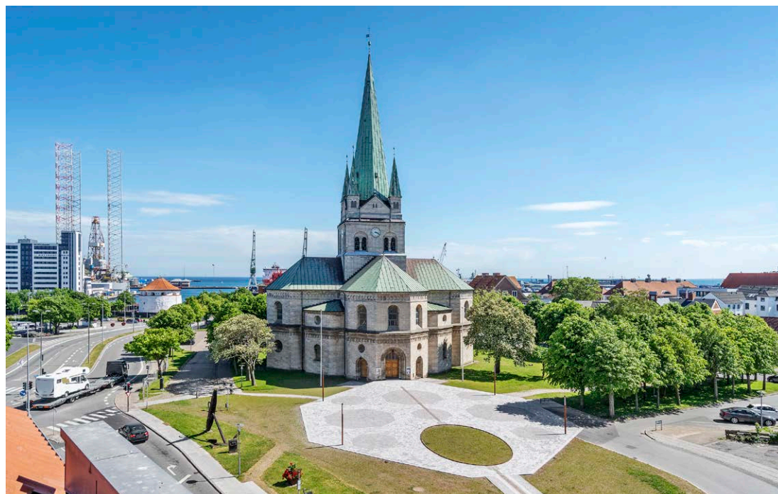
Frederikshavn kirkes nye forplads med brosten og chaussésten formet som en oktagon.
