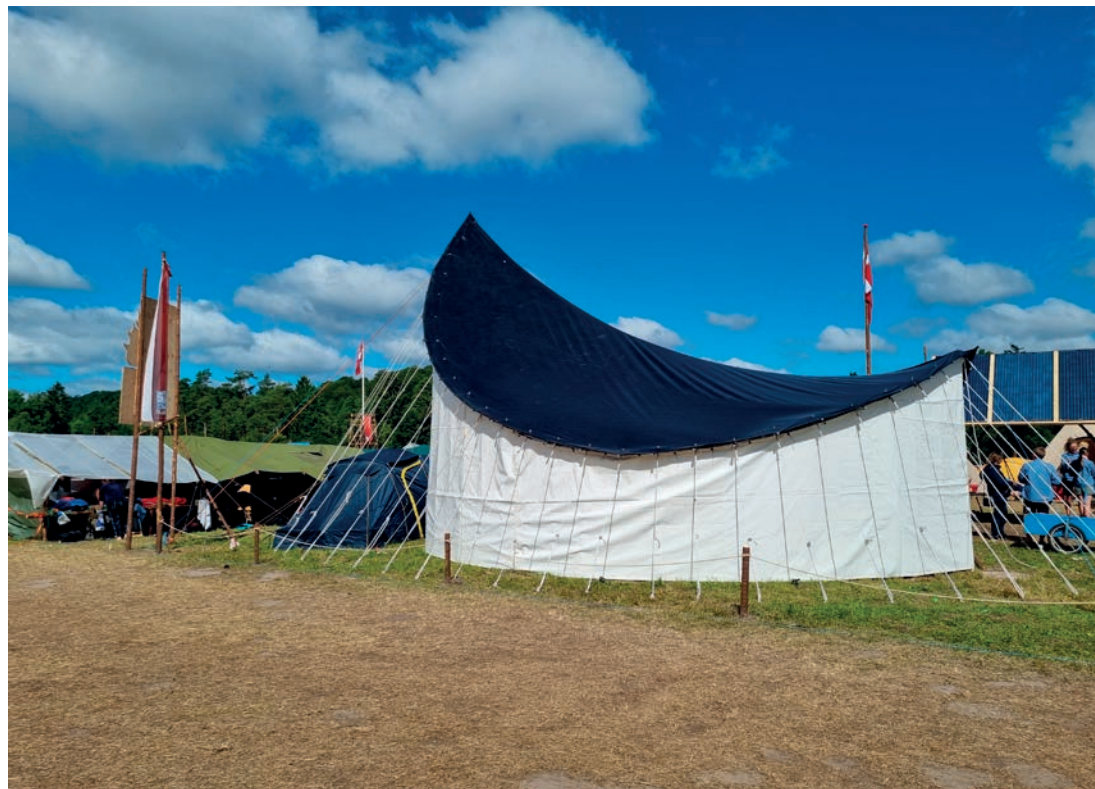
FDF Strandbys samlings-telt på FDFs landslejr 2022 er en model af Strandbys smukke kirke, hvor tagkonstruktionen har form af en hyperbolsk paraboloid
